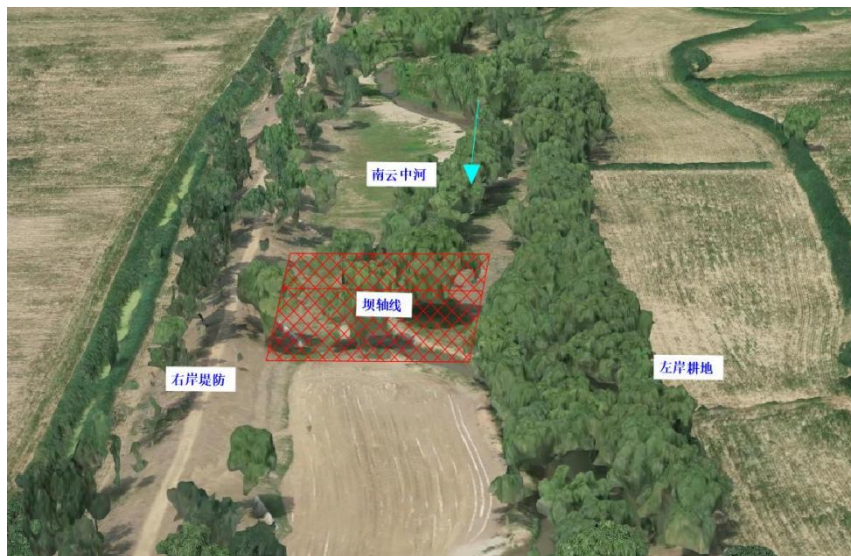
南云中河蓄水坝处现状河道航拍照片
