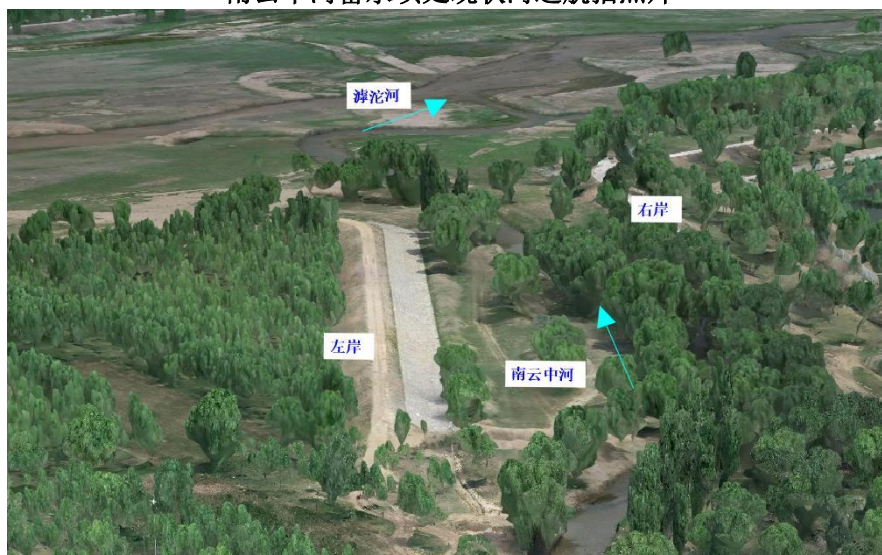
南云中河入河口现状河道航拍照片
