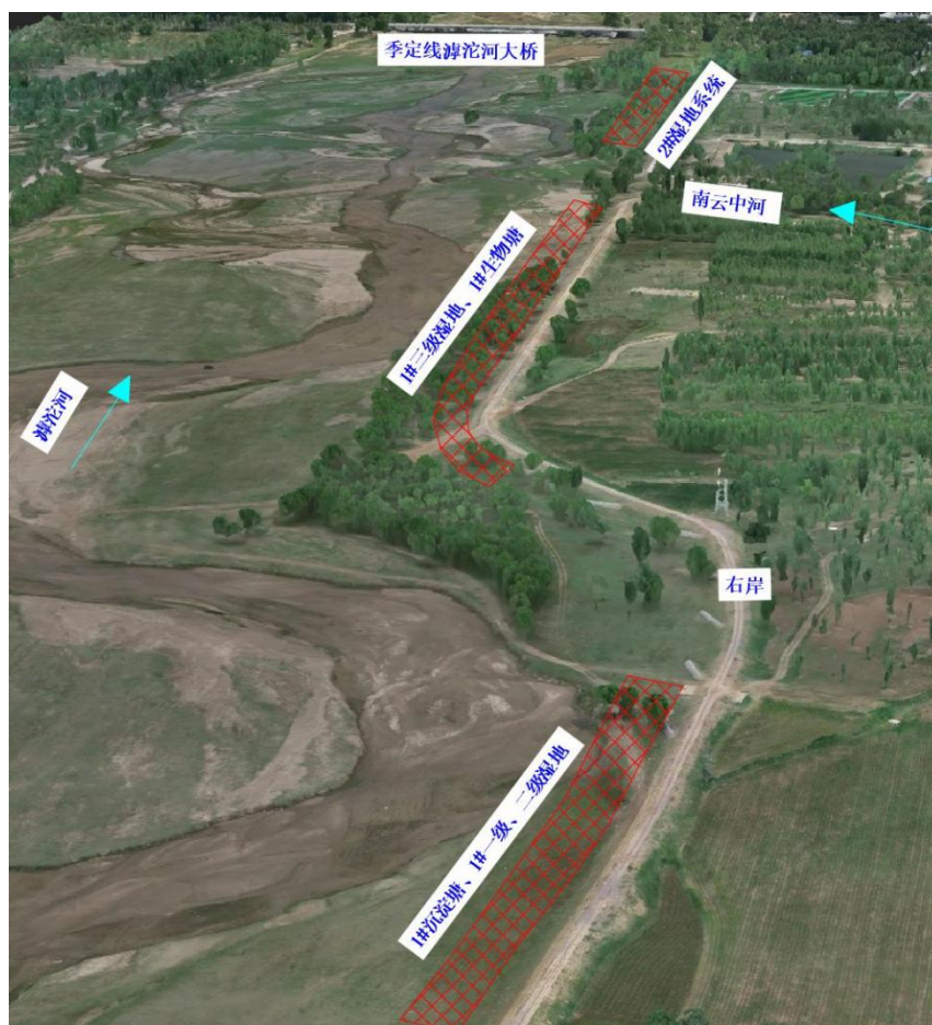
图 3.1-1 滹沱河现状河道航拍照片
